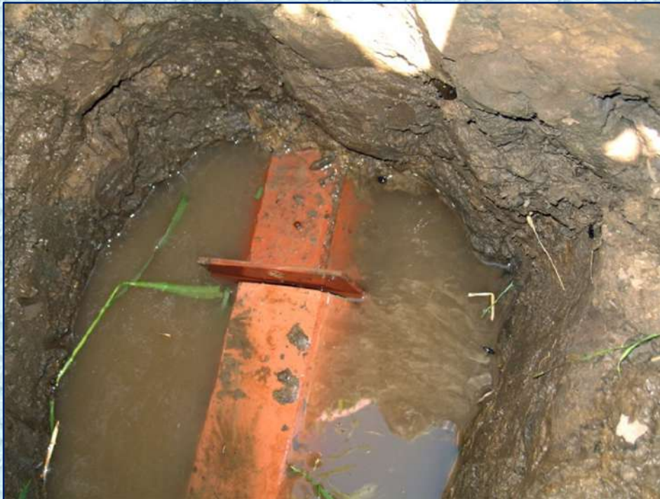
Záslepka na svodném drénu (Foto: Z. Kulhavý)
